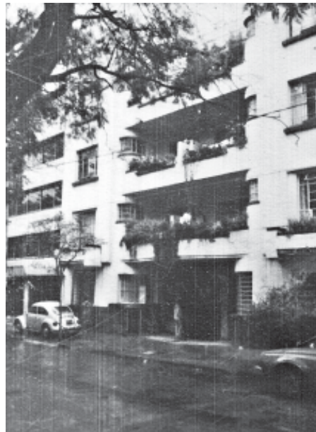
Casa campamento de la Avenida México 33, apartamento E, cuarto piso, entre Sonora y Parras, edificio Roxy, colonia Hipódromo.
